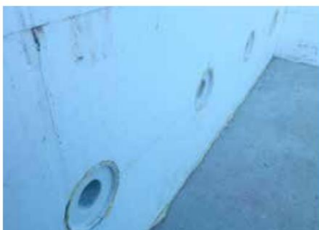
• Færdigt indskummet væggennemføring
